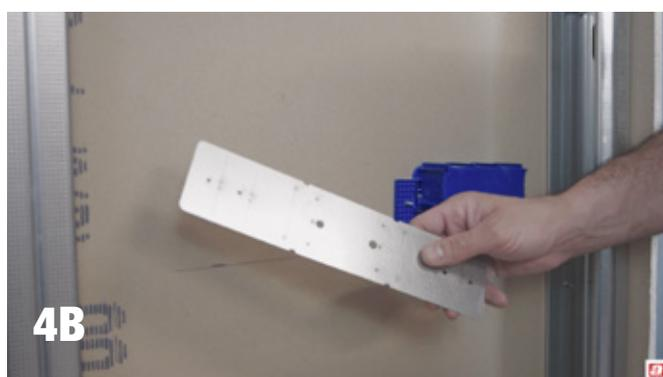
5) Verificare la profondità del montante, se da 75 o 100 mm, e piegare la staffa secondo la lunghezza del fondo della scatola sfruttando gli alleggerimenti posti sui lati della staffa stessa (Fig. 5A). Poi piegare la staffa in base alla profondità del montante fino ad ottenere lo spessore desiderato (Fig. 5B).
