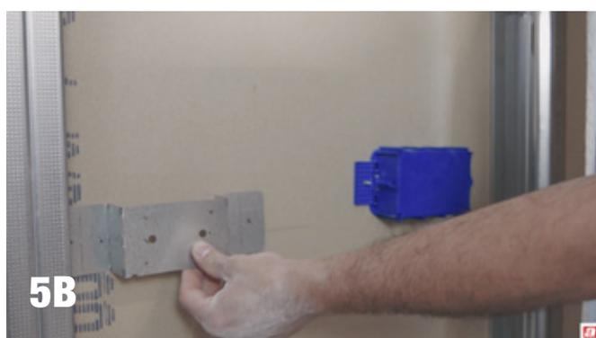
6) Fissare la staffa alla lastra (Fig. 6A); si suggerisce di applicare le viti dal fronte della lastra. Terminare fissando la scatola alla staffa mediante viti (Fig. 6B).
