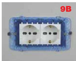
9) Qualora si rendesse necessario, per esigenze di cablaggio / spazio (es. installazione 2 prese schuko - fig. 9B), procedere con l'asportazione delle alette metalliche spezzandole (fig. 9A).
