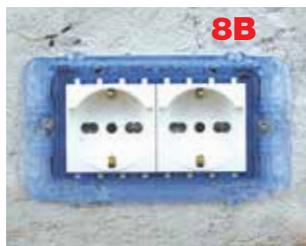
8) Qualora si rendesse necessario, per esigenze di cablaggio / spazio (es. installazione di 2 prese schuko), procedere con l'asportazione delle alette metalliche spezzandole (fig. 8A e fig. 8B).
