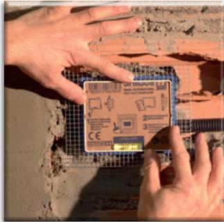
**1** Realizzare la spaccatura e, con la malta, fissare la scatola orizzontalmente avvalendosi dell'apposita livella a bolla fornita in dotazione
