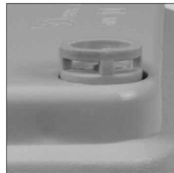
Viti di fissaggio e coperchio predisposti per effettuare l'operazione di piombatura
