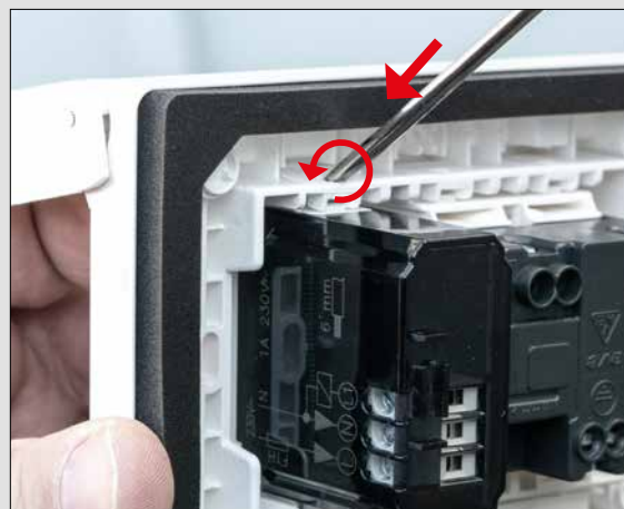
... contemporaneamente, inserire il cacciavite, nell'apposito foro e ruotare per estrarre il frutto. ...at the same time, insert the screwdriver in the dedicated hole and rotate to extract the device
