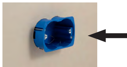
Installazione fronte parete Front wall installation
